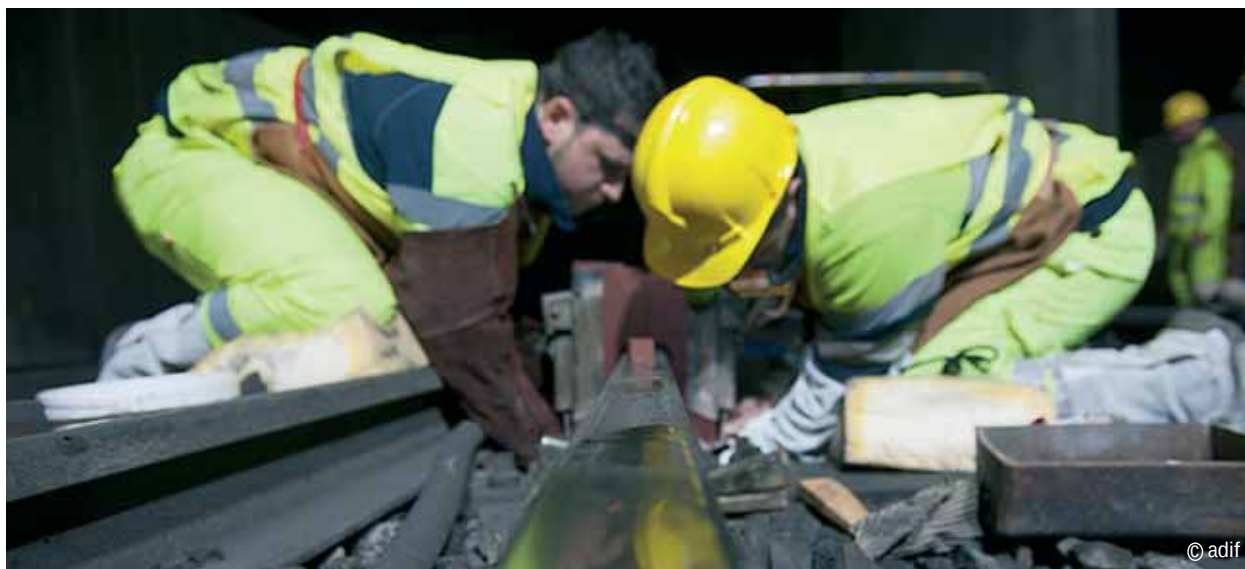
Dos operarios trabajan en labores de seguridad en la vía.
